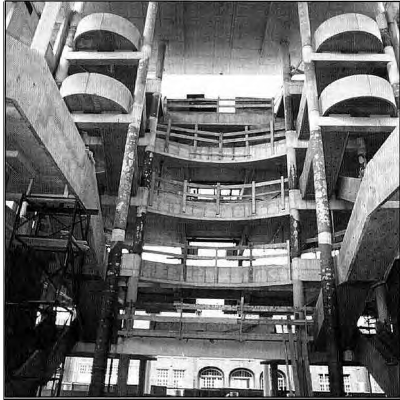
De bouw van het Stadhuis. Foto's: Gemeente Apeldoorn.
