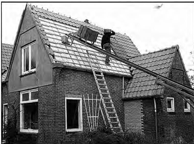
Renovatieproject in uitvoering. Foto: Gemeente Apeldoorn.
