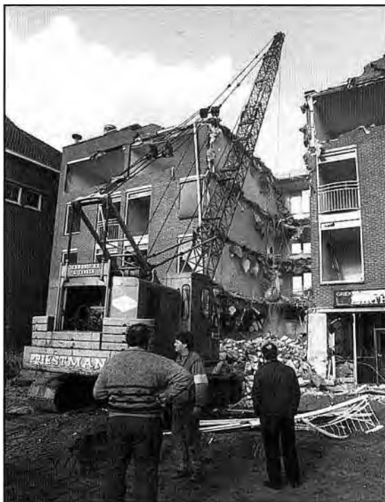
Sloop van de flat op het marktplein. Foto: Gemeente Apeldoorn.
